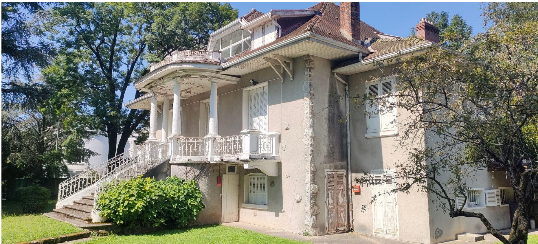
Façade sud de la villa Abeille, faisant face au Lac d'Annecy
